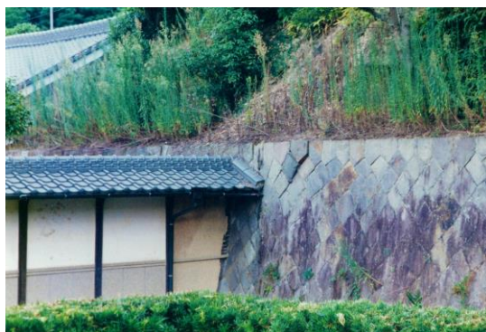
土堀及び石垣擁壁(南西より)
