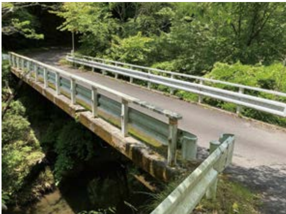
修繕予定の谷田橋
