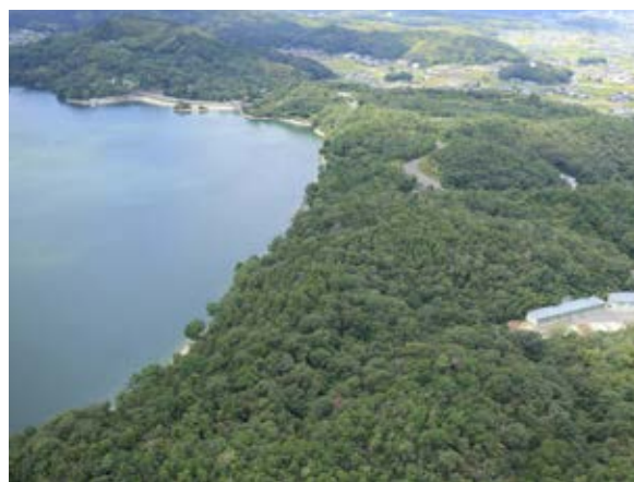
写真4-10 満濃池北岸 東より
