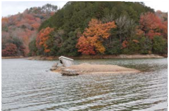
写真4-56 視点場⑧ 山の神社基礎の石積
