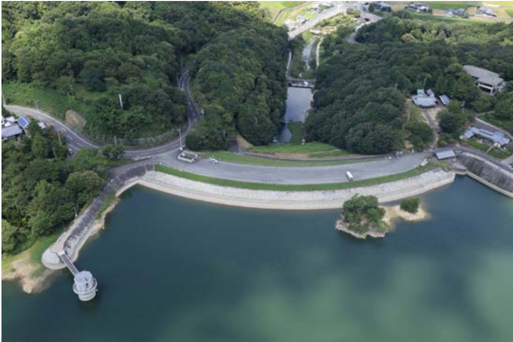
写真 3-2 満濃池 堤体全景(南東より)
