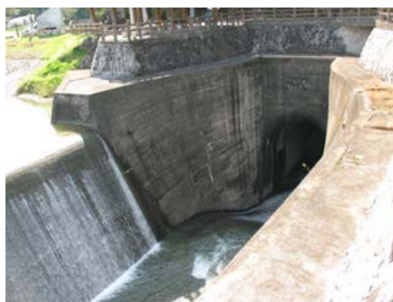
写真4-20 余水吐流入部から暗渠へ注ぐ
