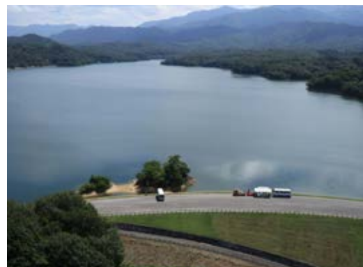
写真4-14 護摩壇岩と取水塔 北より
