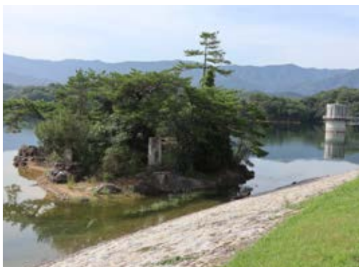
写真4-13 堰堤と水面 西より
