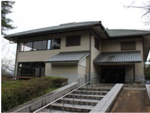
写真4-37 かりん会館 東より
