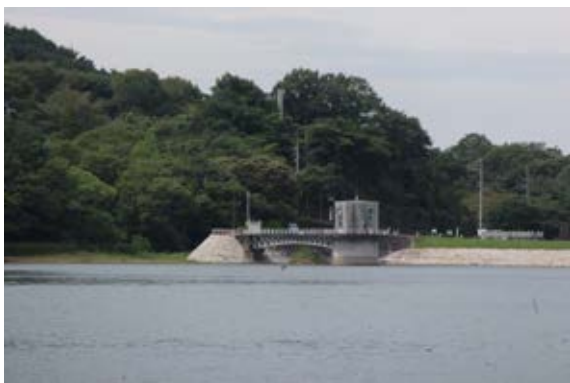
写真4-55 視点場⑦ 取水塔
