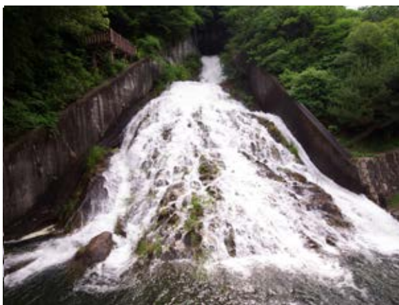
写真4-21 余水放水の様子
