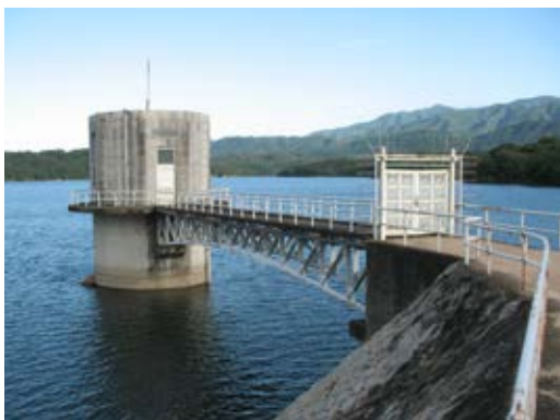
写真5-19 取水塔 北西より
