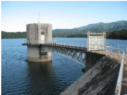
写真4-15 満濃池取水塔
