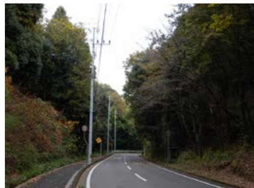
写真5-20 道路沿いの工作物 北西より
