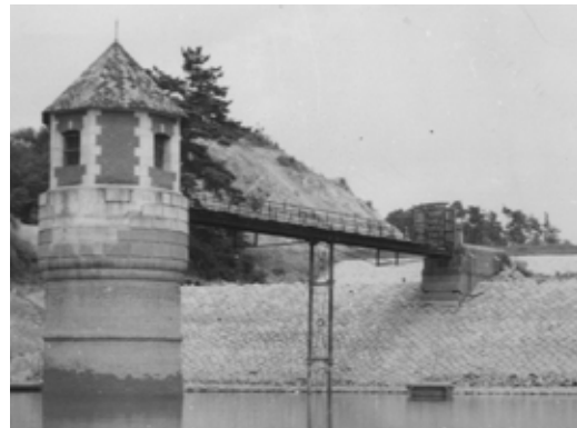
写真4-16 赤レンガ取水塔
