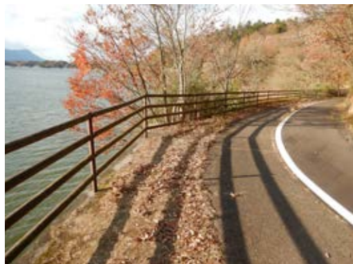
写真5-22 北岸の町道 南東より
