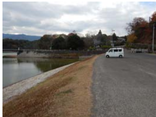
写真5-4 堰堤上 北東より
