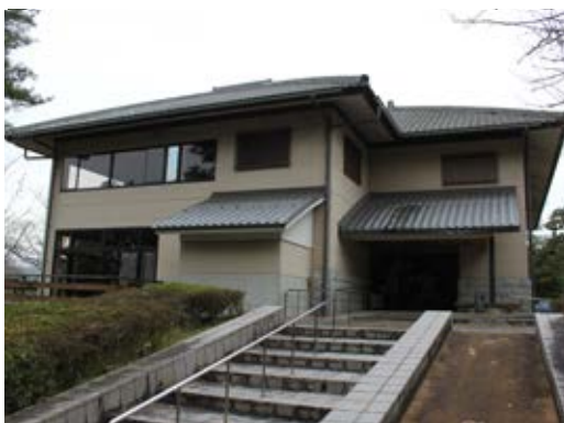
写真5-11 かりん会館 東より
