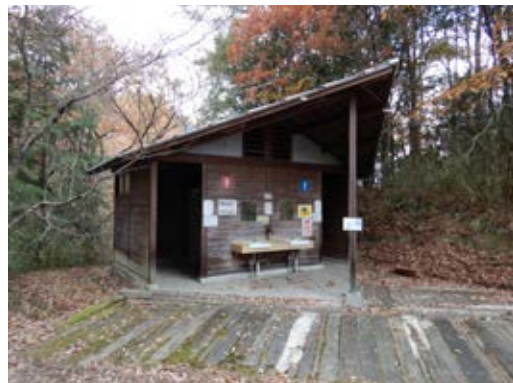
写真5-30 トイレ 南より
