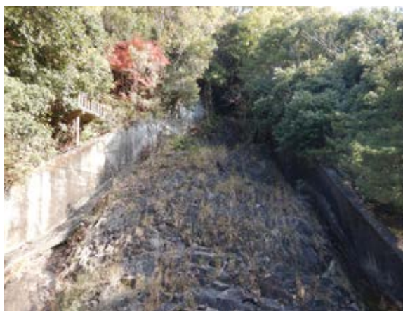
写真4-22 余水吐出水口の水路床
