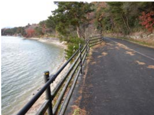
写真5-9 北岸の町道 東より
