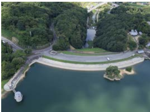
写真4-3 堰堤 南東より
