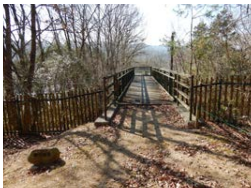
写真5-23 岬の栈橋 北より
