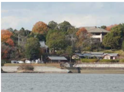
写真5-13 建築物の遠景 南東より
