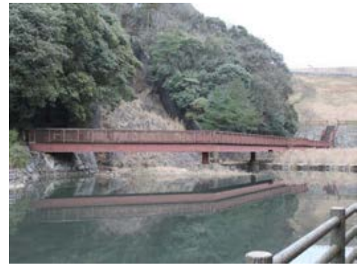
写真4-38 堰堤下流側のデッキ 南西より
