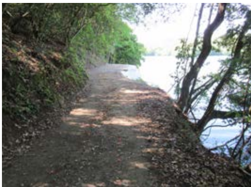
写真5-31 南岸の町道 南東より
