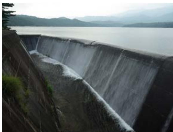
写真4-19 余水吐へ流入する池水
