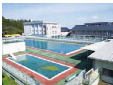
取り壊し予定の旧仲南町民プール
