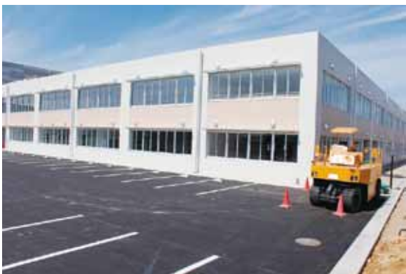
県外業者 施工部分
