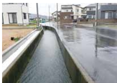
増水した水路
