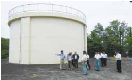
天神山配水池の委員会視察
