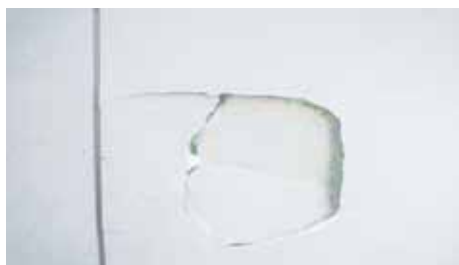
穴のあいた体育館の内壁
