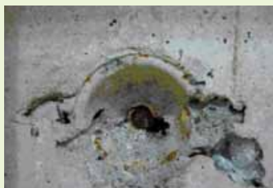
錆びたセパ穴の鉄筋 (写真①)
