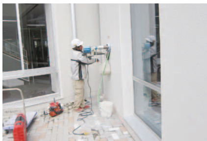
コア抜き検査の様子
