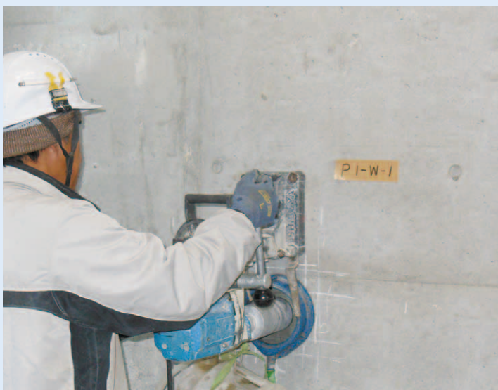
コンクリート強度試験のために 壁の一部を抜き取っている作業の様子
