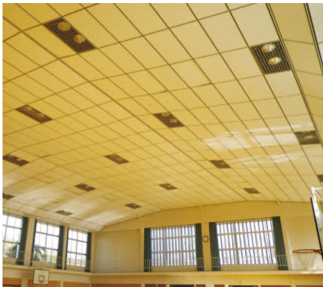
天井撤去する仲南小学校体育館
