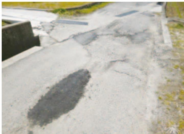
陥没箇所所の応急処置のようす
