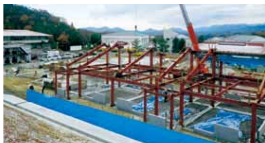
工事が進む仲南こども園
