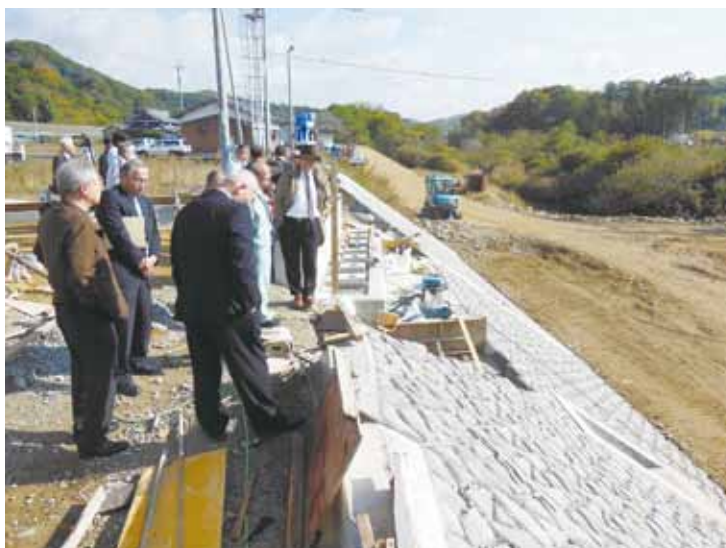
工事が進む道德寺橋架け替え工事
