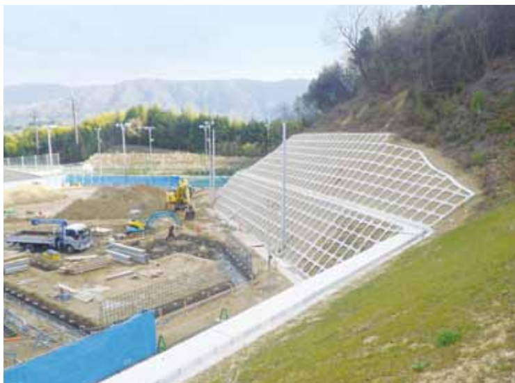
崩落の危険のある法面の修繕
