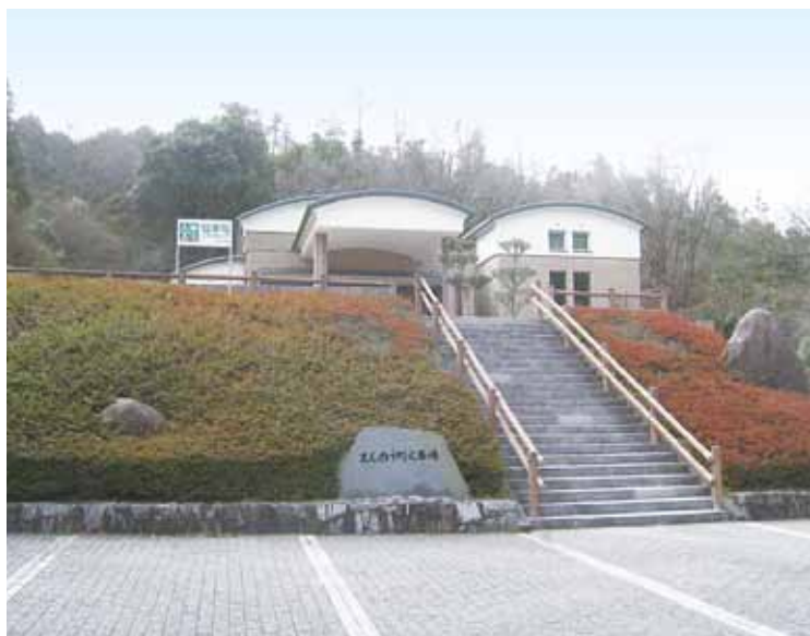
火葬炉を改修する斎場
