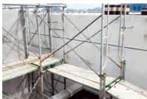
改修中の高篠小学校
