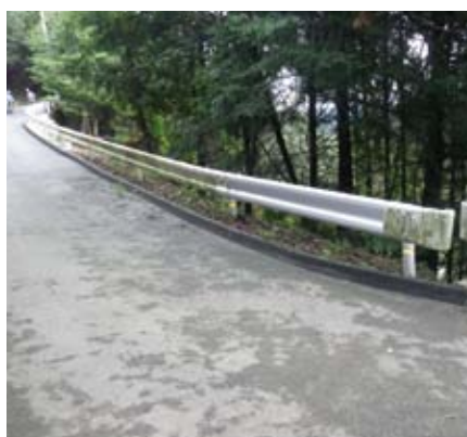
修繕が終わった林道（西谷線）
