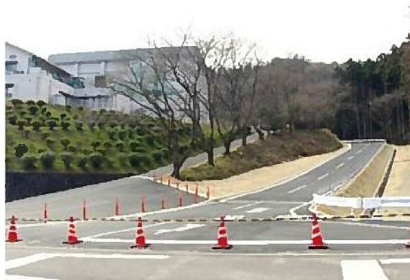
新しくなる進入路（仲南支所）
