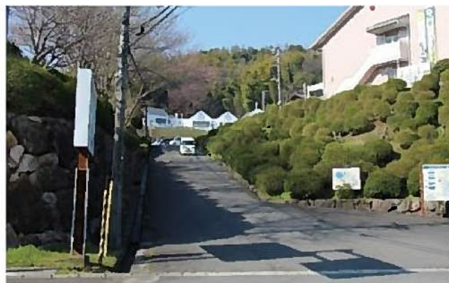
町所有地に立つ道路占作物（電柱）
