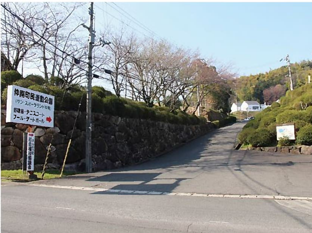
閉鎖予定の進入路
