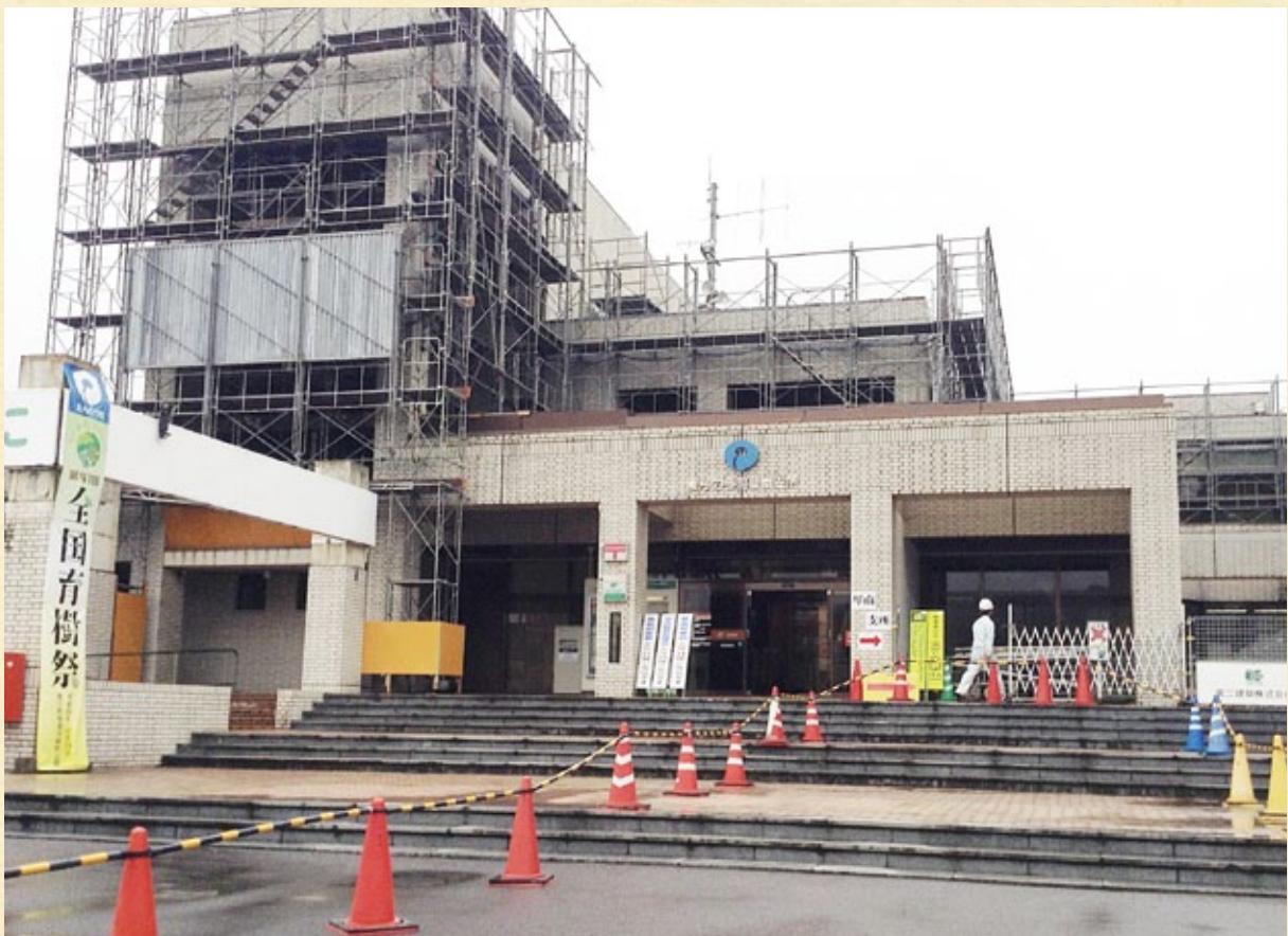
来春に改修完了予定(琴南支所)
