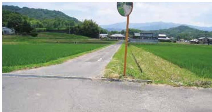
町道片岡線改良事業 4m→6mに拡幅
