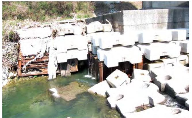
洗掘された満濃大橋橋脚の補強
