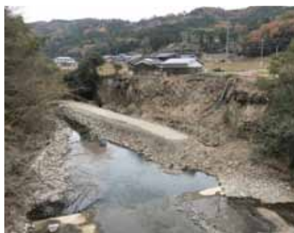
—琴南川東地区— 土器川護岸工事
