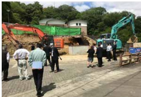
待合室の増築工事
