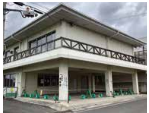
児童館を撤去してトイレを整備
