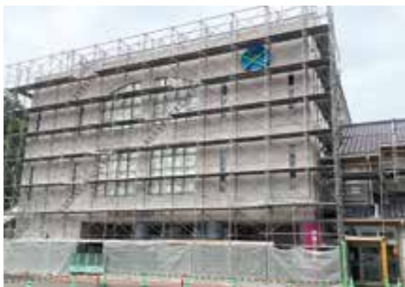
吊り天井を撤去工事中（町民文化ホール）
