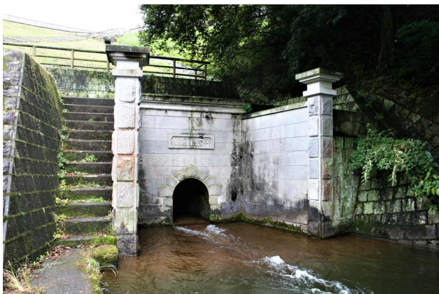
満濃池樋門 全景(西より)
