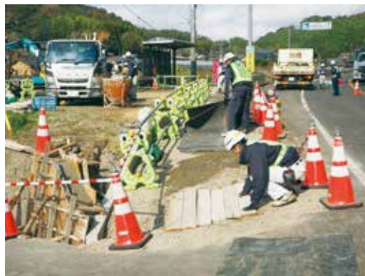
国道32号の歩道改良
