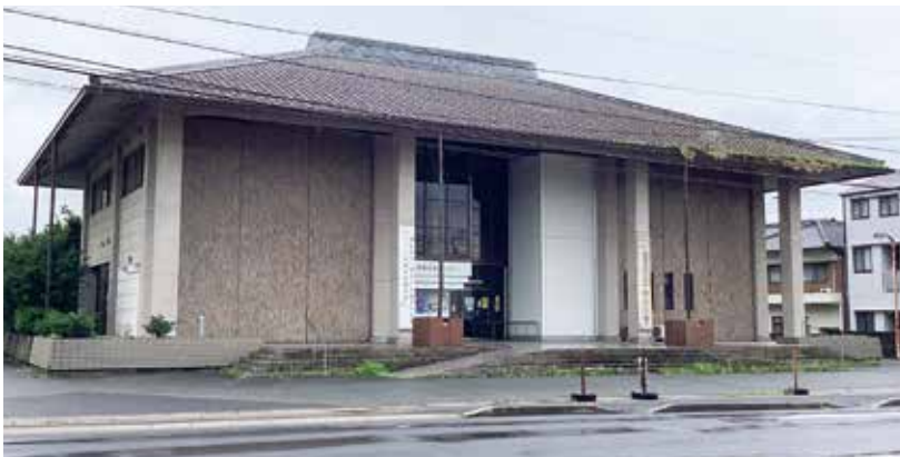
解体工事が始まります
