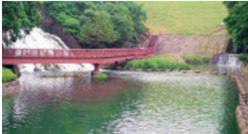
Voici la cascade mirage que l’on ne peut voir que quand l’étang devient plein et que l’eau est relâchée par le canal d’évacuation vers la rivière de Kanakura.
