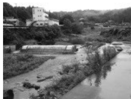
満濃導水頭首工
