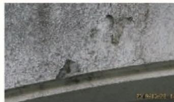
外壁のコンクリートが爆裂、錆びた鉄筋が見えている
