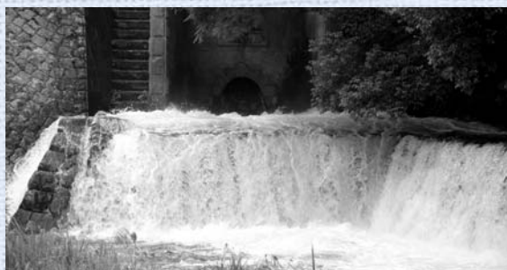
▲樋門から勢いよく放水されています
