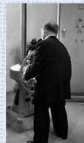
▲配水塔で水門を開放
